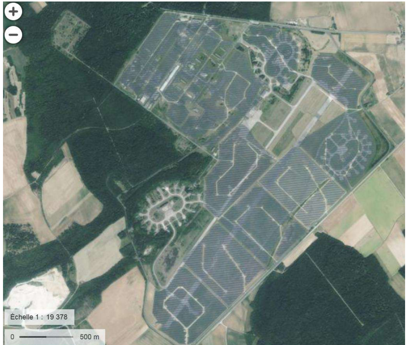
Station solaire de Toul
